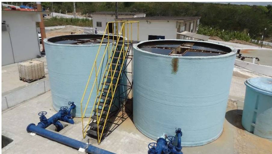
Figura 07 – Filtros Russos em fibra de vidro.
