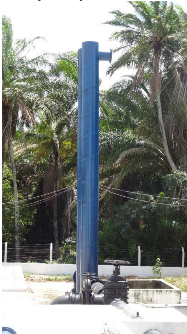
Figura 03– Torre Piezométrica
