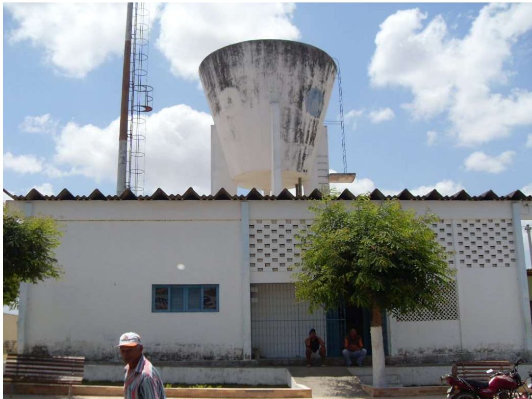
Figura 21 – Reservatório elevado-150m 3 –Montanhas
